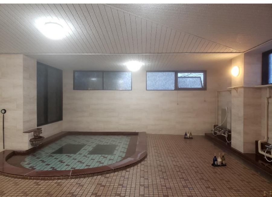
女子浴室の壁（化粧板）の全面張替え を致しました。
