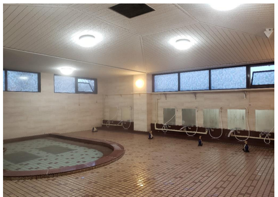
女子浴室の天井を塗装致しました。
