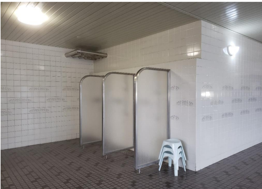
男子浴室奥右 立ちシャワー仕切り板の交換。
